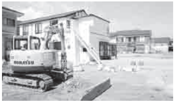
▲旅館裏手に回ると未だ復旧工事途上
